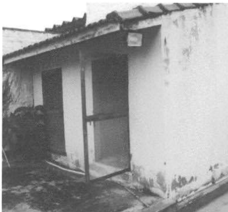
FIGURA 9: DEPÓSITO DE RSS DO HOSPITAL MATERNIDADE NOSSA SENHORA DA GLÓRIA.
