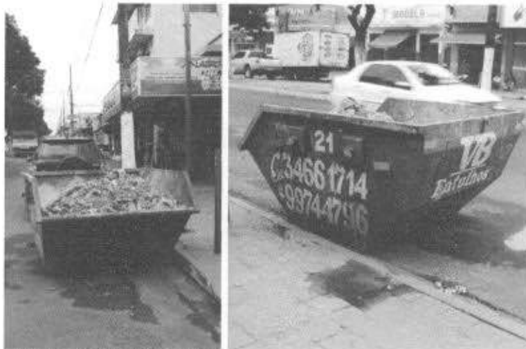
FIGURA 7: CAÇAMBA DE COLETA DE ENTULHOS.
