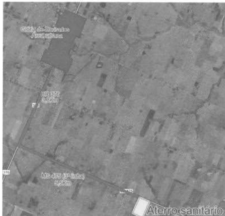
FIGURA 16: LOCALIZAÇÃO DO ATERRO SANITÁRIO CONSORCIADO EM RELAÇÃO À ÁREA URBANA DE GLÓRIA DE DOURADOS.
